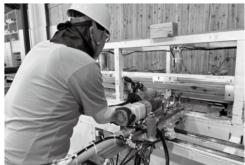
機械打ちのビスでパネルを留め付ける
