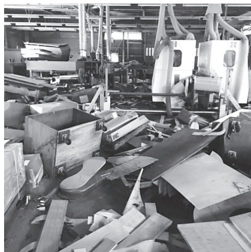
被災後の工場内の様子
