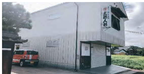
<製造所側外観>
