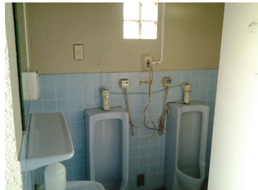
図表 2-4 駐車場内のトイレ内部
