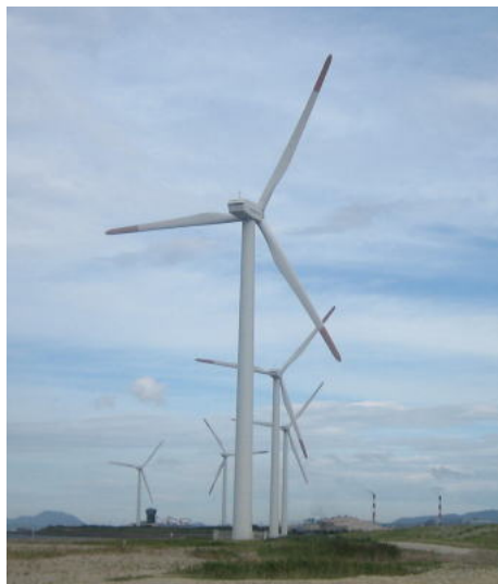
図表 3-3-1 : NS ウィンドパワーひびき (福岡県北九州市)
