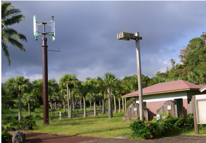
図表 3-3-6：八丈植物公園内 2kW クラスエネルギープロダクト社製小型風力発電機
