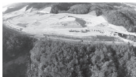
野蒜高台エリア防災集団移転先造成の様子（平成26年11月現在）
